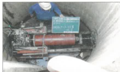
【インナーチューブ使用による推進状況】
