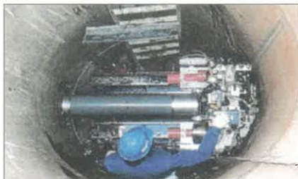
【ステンレスカラー付塩ビ管推進状況】
