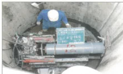
【塩ビ管推進状況】
